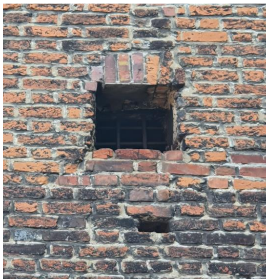
Rys.1 Istniejące skratowanie w jednym z otworów wieży prudnickiej w Białej.
